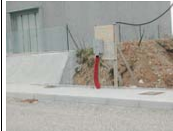
Situazione regolare, gli elementi in tensione sono correttamente protetti
