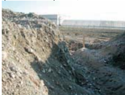
Situazione non regolare, il fronte dello scavo non è inclinato e può franare; non ci sono segregazioni dell'area alla base e sul ciglio dello scavo
